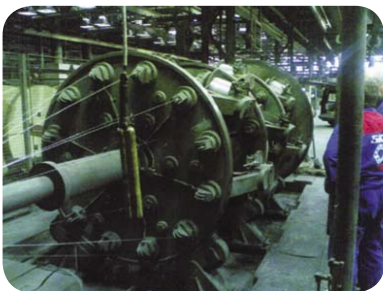
Slaňovací stroje (měření geometrie a ustavení celého zařízení)
